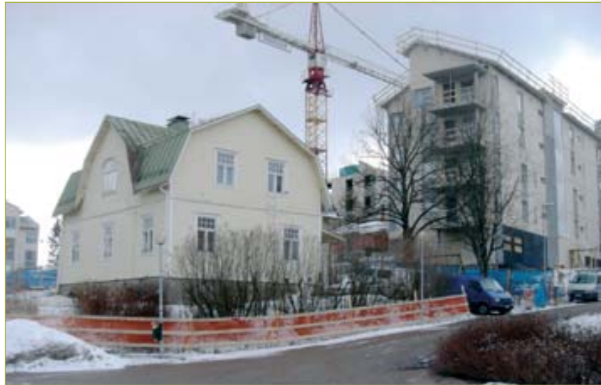
Kirkkonummen kuntakeskuksen kehittäminen on edennyt suunnitteluvaiheesta rakentamiseen. Liikealueelle on kaavoitettu asuntoja yli tuhannelle asukkaalle. Kuvassa Lukkarinmäen rakenteilla olevia kerrostaloja. Kuvaaja: Mikael Pettersson.
