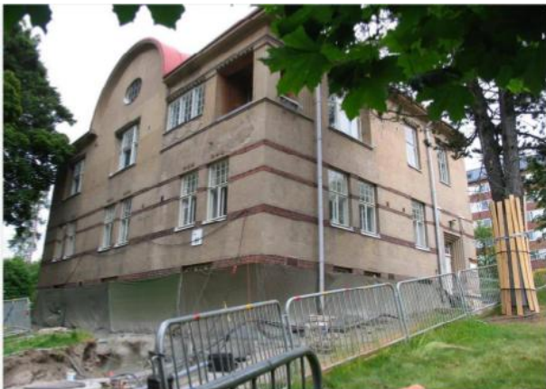
Koskelan sairaalan H-rakennuksen salaojien sadevesijärjestelmän uudistaminen. Oikealla Leikkipuisto Portti, paviljonkipäiväkoti Kesällä 2009.
